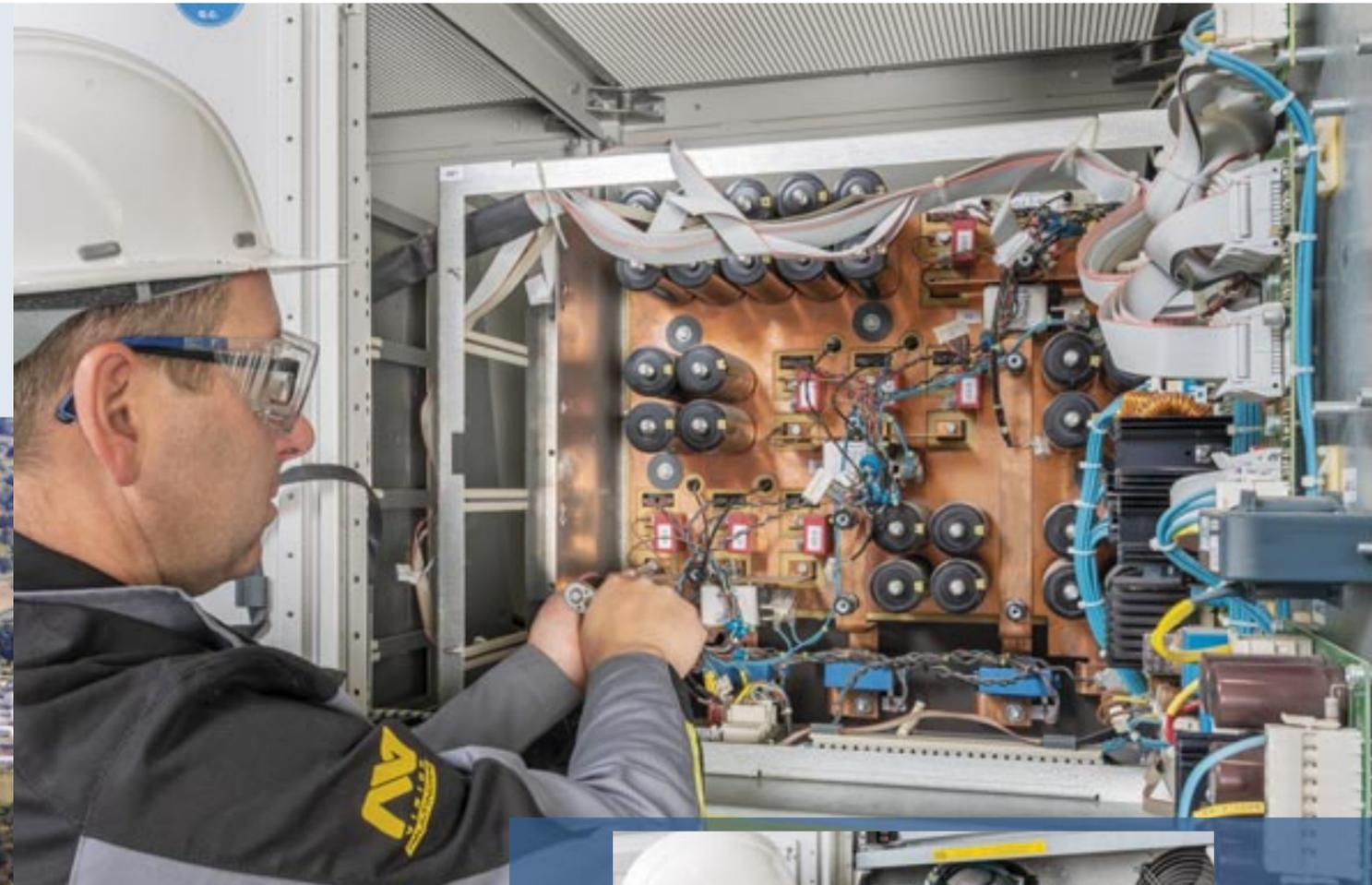
Der Austausch von elektrischen Komponenten, wie z. B. der IGBT-Treiberkarten oder Zwischenkreiskondensatoren, setzt ein komplexes Anlagen-Know-how voraus.
