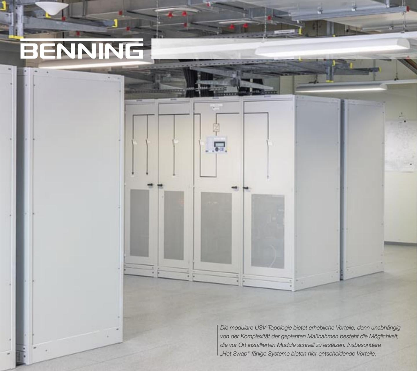
Die modulare USV-Topologie bietet erhebliche Vorteile, denn unabhängig von der Komplexität der geplanten Maßnahmen besteht die Möglichkeit, die vor Ort installierten Module schnell zu ersetzen. Insbesondere „Hot Swap“-fähige Systeme bieten hier entscheidende Vorteile.
