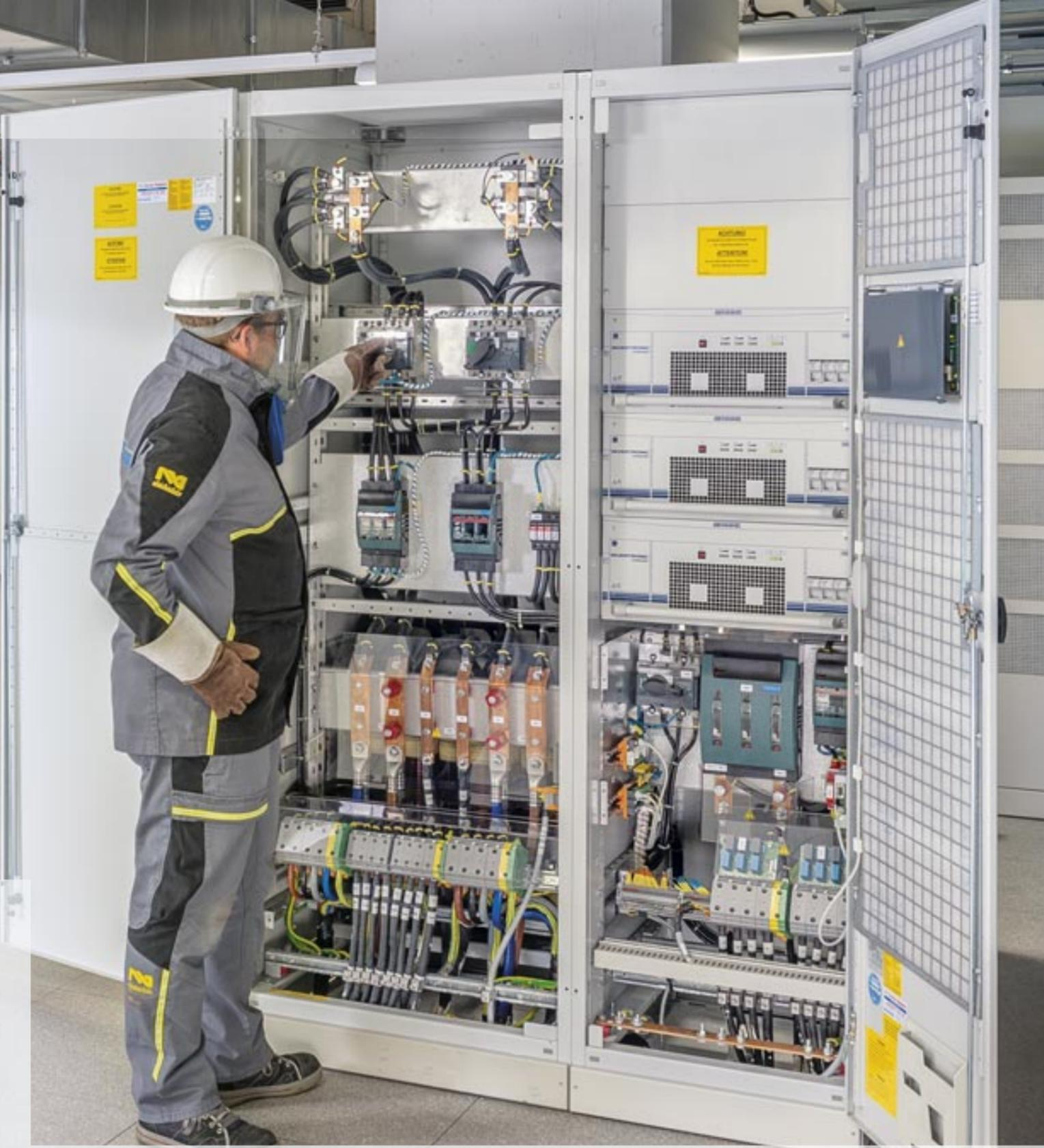
In Verbindung mit großen Batteriekapazitäten gewährleisten diese Systeme eine gesicherte 220 V / 24 V Gleichspannungs- und 400 V Wechselspannungsversorgung. Zusammengefasst beträgt die vor Ort installierte Gesamtleistung mehr als 1,6 MW DC und 1 MW AC.
