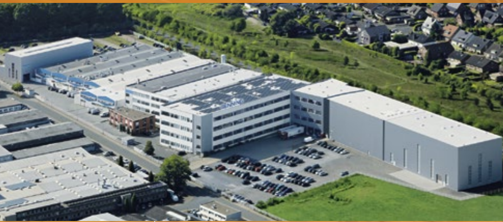
BENNING Werk 2, rechts im Bild das erweiterte Hochregallager
