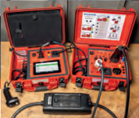
Prüfung einer 3-phasigen Ladeleitung Mode 2
